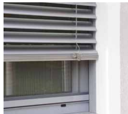
žaluzie v podomítkovém provedení schráanky a vodičích lišt
