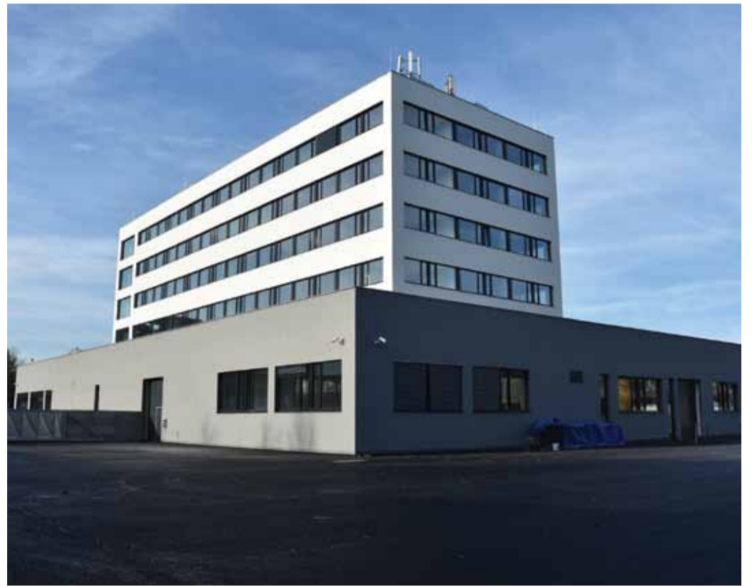
pro celou realizaci bylo klíčové správné navržení statiky prvků, foto zdroj: Archide CZ spol. s r.o.
